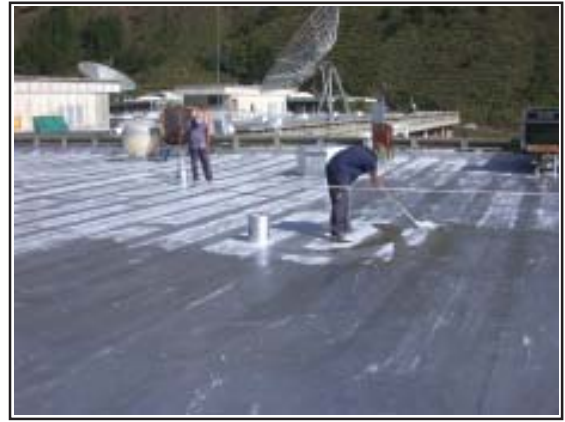
Impermeabilización de techo del Edificio A de la Facultad de Ciencias.
